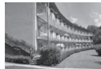
Die Bauarbeiten zum Pflegeheim auf der Laßnitzhöhe starten.
